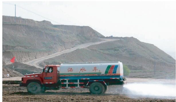
图9 低含水率土料翻倒补水掺和
