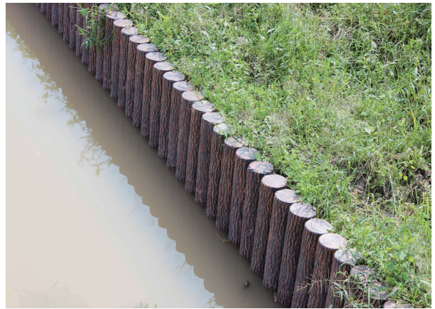
图5 直接打入式仿木桩
