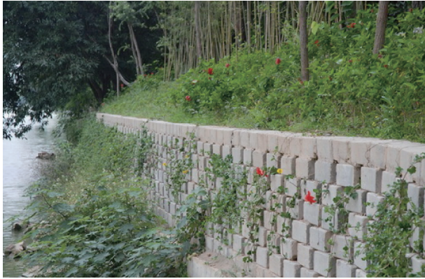
图2 混凝土预制嵌块加筋土挡墙
