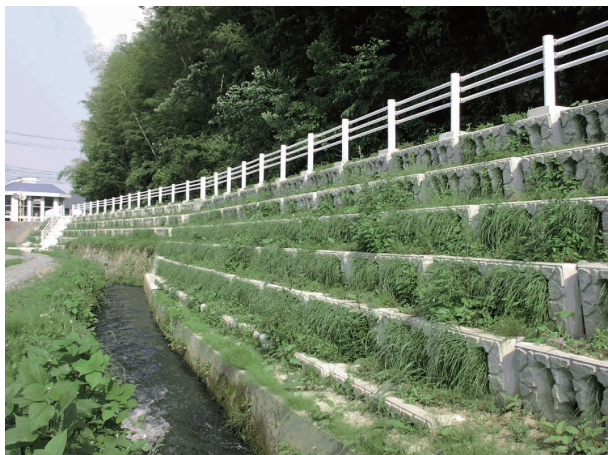
图1 混凝土预制箱型砌块挡墙
