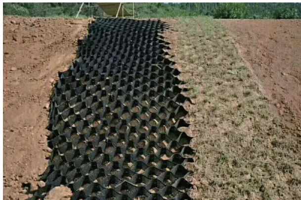
图 6 土工格室护坡
